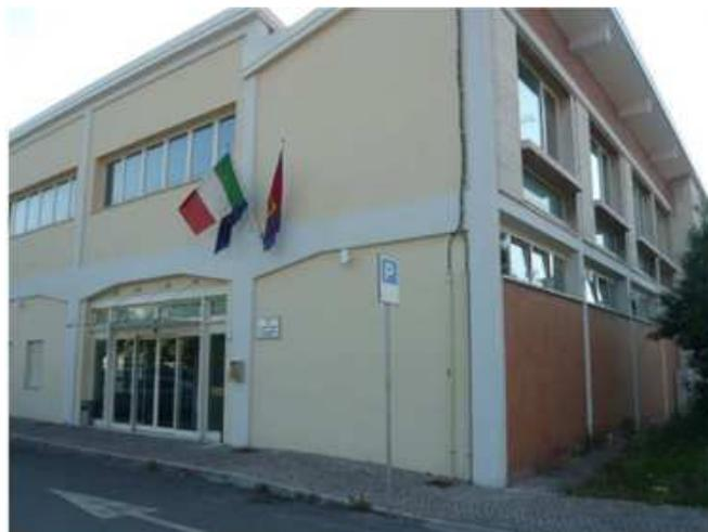
**Dimensioni :** Edificio per uffici, isolato, pianta articolata, 2 piani fuori terra Strutture verticali e orizzontali in c.a. e laterocemento, tamponamenti in laterizio intonacato e a vista, coperture con solai in laterocemento
